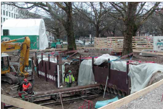
14 Rohre werden unter die Wurzelballen jedes Baums getrieben und bilden eine Transportplattform.
