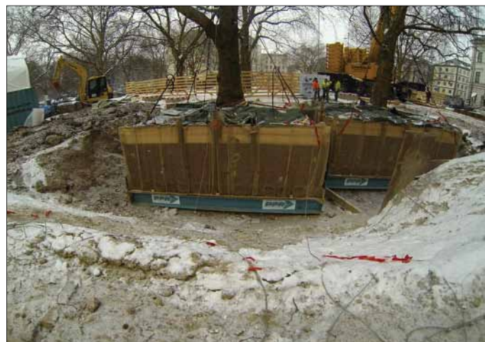
Plattformen mit fertiger Transportabspannung
