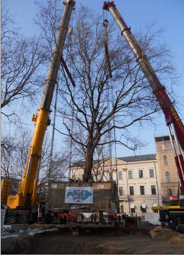
Zwei Krane heben die erste Platane aus ihrem ursprünglichen Standort.
